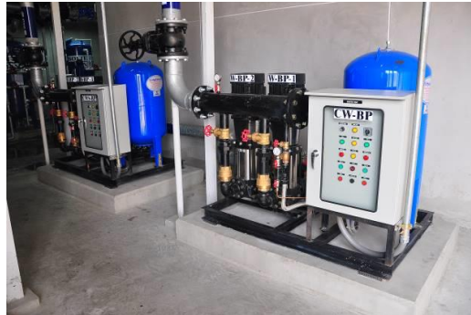
งานระบบประปา
