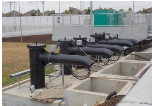
งานระบบระบายน้ำ
