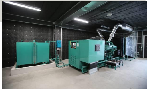
งานระบบไฟฟ้าสำรอง (เครื่องกำเนิดไฟฟ้า)
